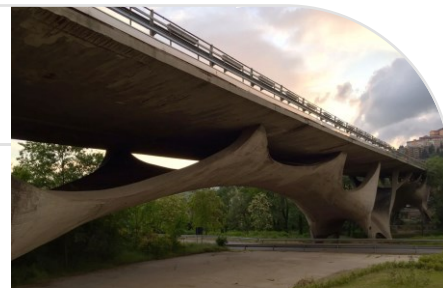
Potenza, Ponte Musmeci sul Basento - Inarcassa 2016
