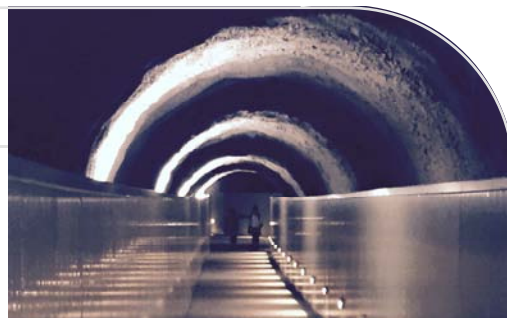
Courmayeur, Tunnel dello Skyway Monte Bianco - Inarcassa 2015
