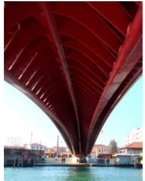
Venezia, Ponte Calatrava - foto di A. C. Brighenti, 2012
